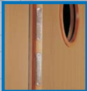
Kennzeichnungsschilder der Brandschutzzulassung
